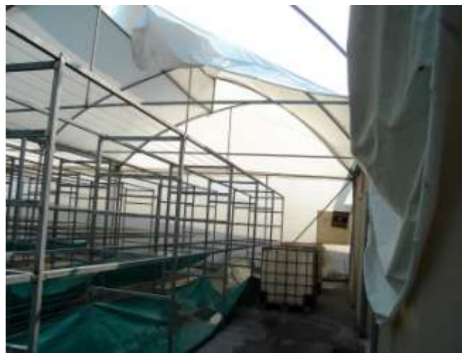
Nopaloteca en construcción
